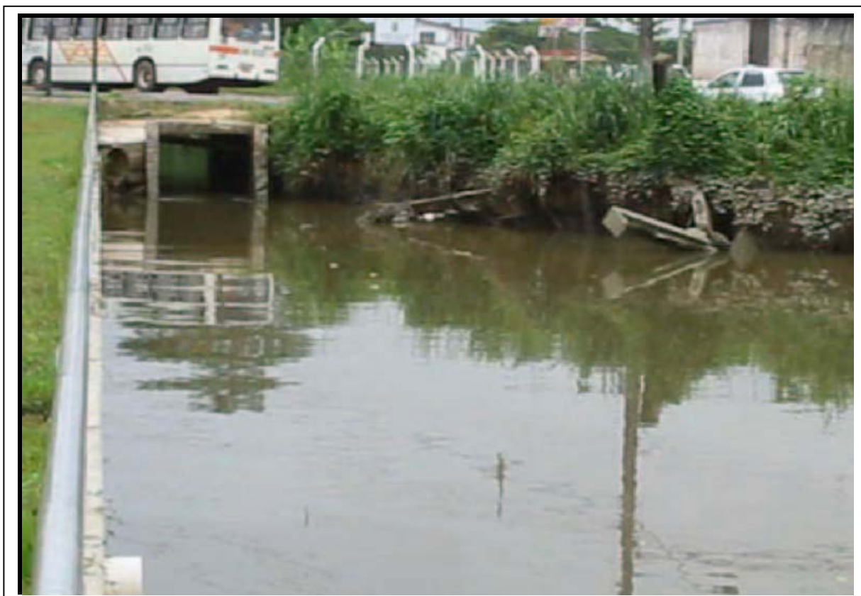
Figura 12: Rodovia Arthur Bernardes construída acima do canal de retificação do Igarapé Val-de-Cães, rompendo com a dinâmica do curso d'água, estrangulando seu fluxo, a exemplo de um funil.
